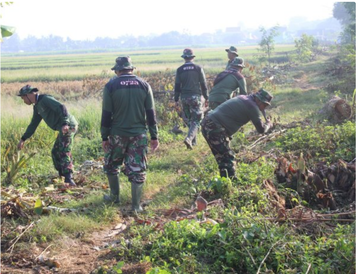
Warga Klaten dan TNI Siapkan Lokasi Betonisasi TMMD Reg 121
